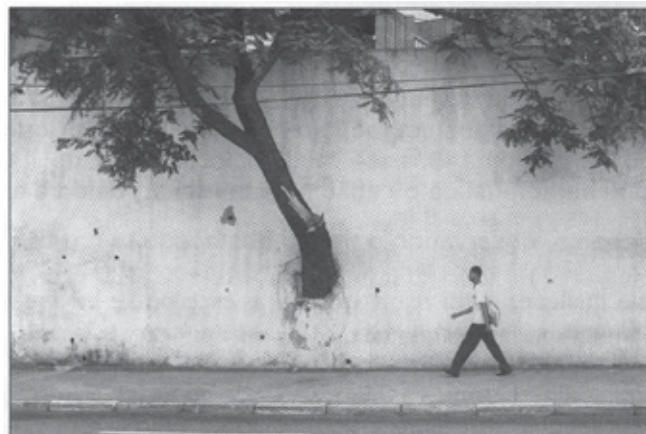
Árvore cresce no meio de um muro na Avenida Padre Lebrez, no Morumbi, zona sul de São Paulo
