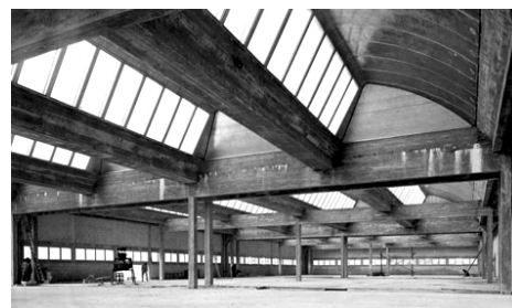
Sheds da Casa de Impressão MAME, Tours, 1950
