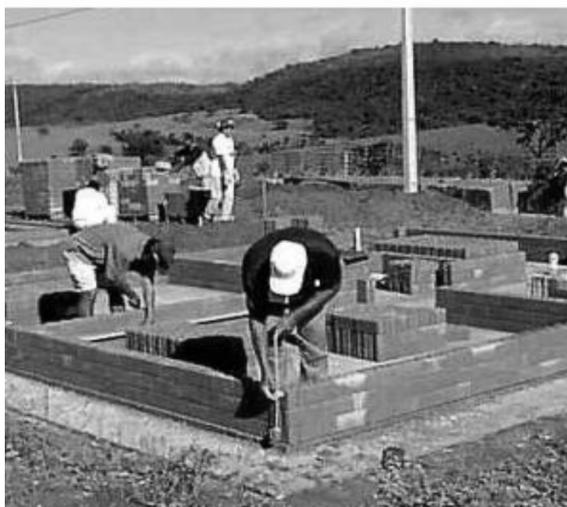
A imagem apresenta alguns descuidos quanto à proteção individual dos trabalhadores na execução de trabalhos de elevação de alvenaria. Os Equipamentos de Proteção Individual – EPI que devem ser utilizados, dentre outros, neste tipo de serviço são:
