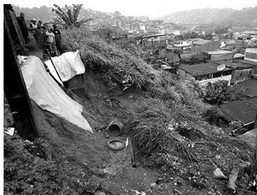
Deslizamento de terra em Salvador (BA)
