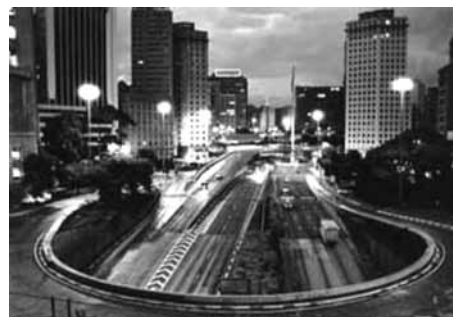
Fig. 02 – Vista sobre Viaduto do Chá – 1998
