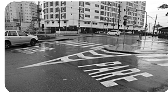
Avenidas Rei Alberto I e San Martin foram beneficiadas
